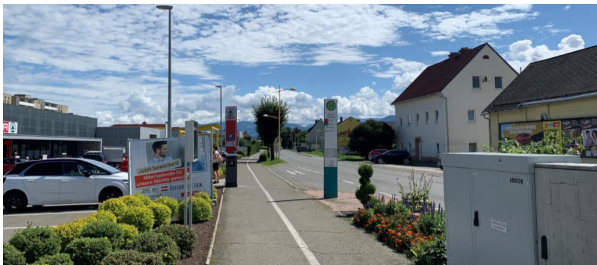
Abbildung 15: Zu schmaler getrennter Geh- und Radweg sowie durch Hindernis (Mülleimer) eingeschränkte Gehwegbreite
