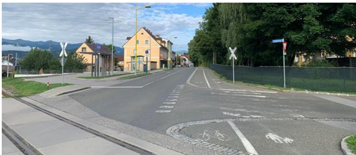
Abbildung 14: Schlecht sichtbare Bodenmarkierung eines Schutzweges
