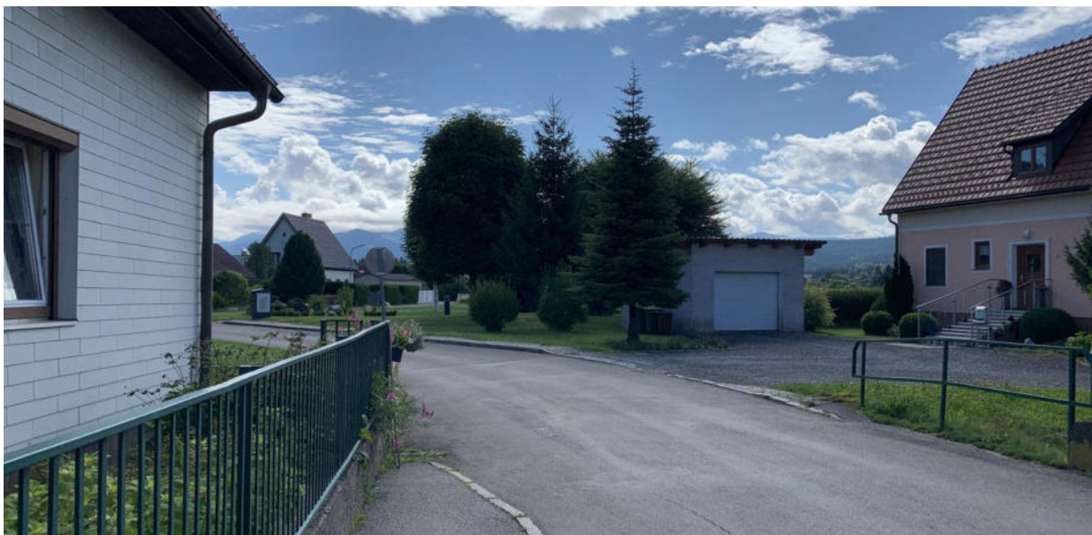
Abbildung 18: Schotterablagerung im Gehsteigbereich
